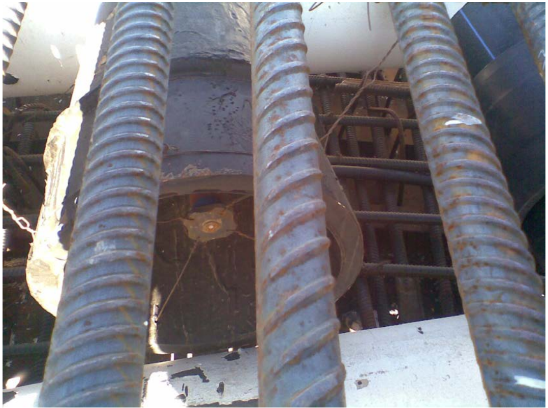
Рисунок 1.18. Усадочный конус с датчиком ПЛДС, вмонтированным в армокаркас купольной части герметичной оболочки
