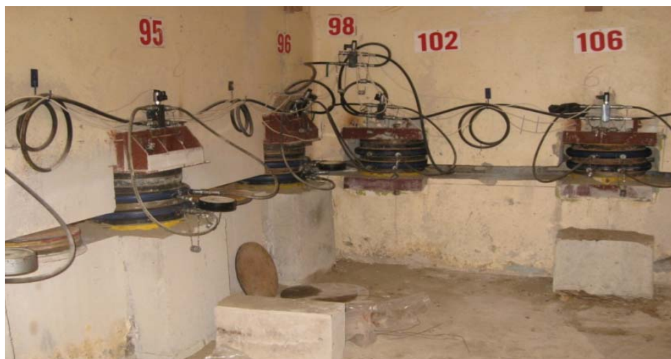
Рисунок 9. Система подъема и выравнивания здания
